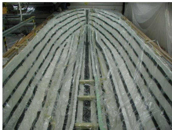
8.1.16. ábra: A sablonba bekerültek a gyantavezetők a tépő-szövet és a száraz laminát fölé
